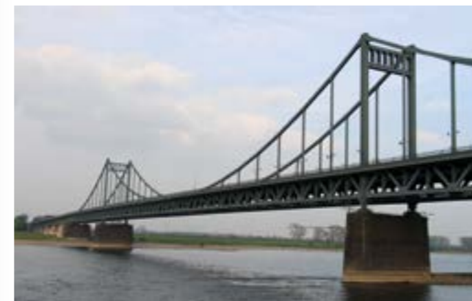
Rheinbrücke Krefeld-Uerdingen Stromkilometer 764,04 Typ: Zügelgurtbrücke Nutzung: Straße (B 288) Baujahr: 1950 (1945 zerstört, 1949/50 in alter Form wieder aufgebaut), denkmalgeschützt Länge: 860 Meter © pixabay
