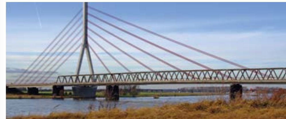
Niederrhein-Brücke Wesel Stromkilometer 813,89 Typ: Schrägseilbrücke Nutzung: Straße (B 58n) Baujahr: 2009 Länge: 772,5 Meter
